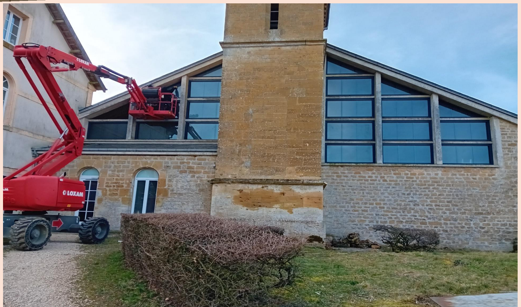
Remplacement de la verrière à l'arrière de l'église
